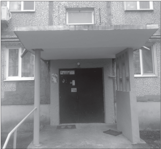
Ремонт під'їзду будинку № 19 на просп. Юності
