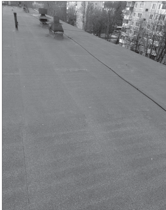
Оновлена м'яка покрівля будинку № 5 на просп. Космонавтів
