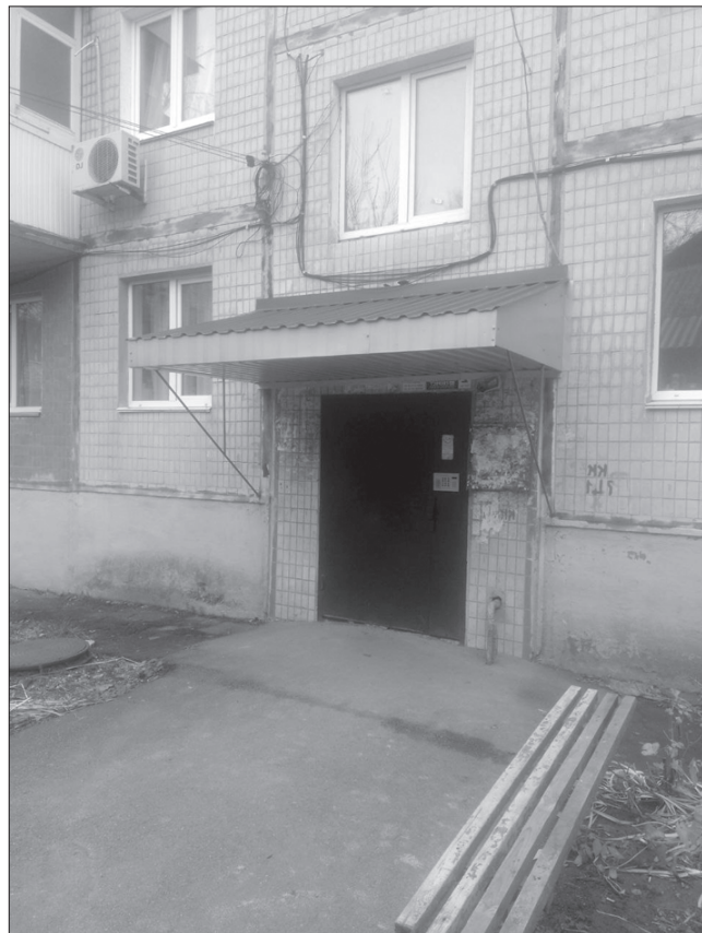
Ремонт козирка над під'їздом буд. № 14 на вул. 600-річчя
