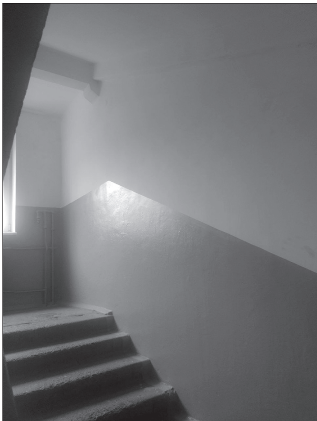
Ремонт сходових клітин у буд. № 4 на вул. 600-річчя
