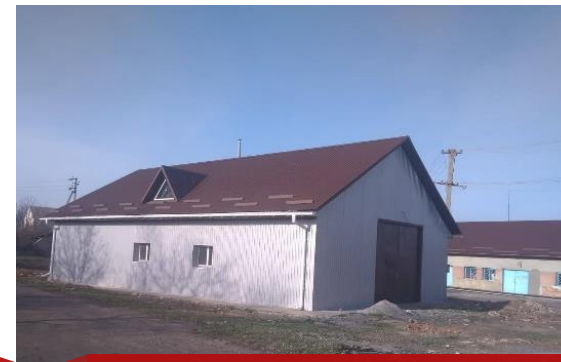
Реконструкція будівлі пожежного депо Северинівська ОТГ
