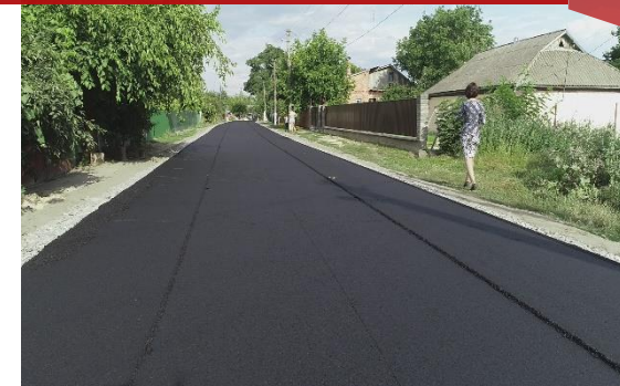
Капітальний ремонт дорожнього покриття Іллінецька ОТГ
