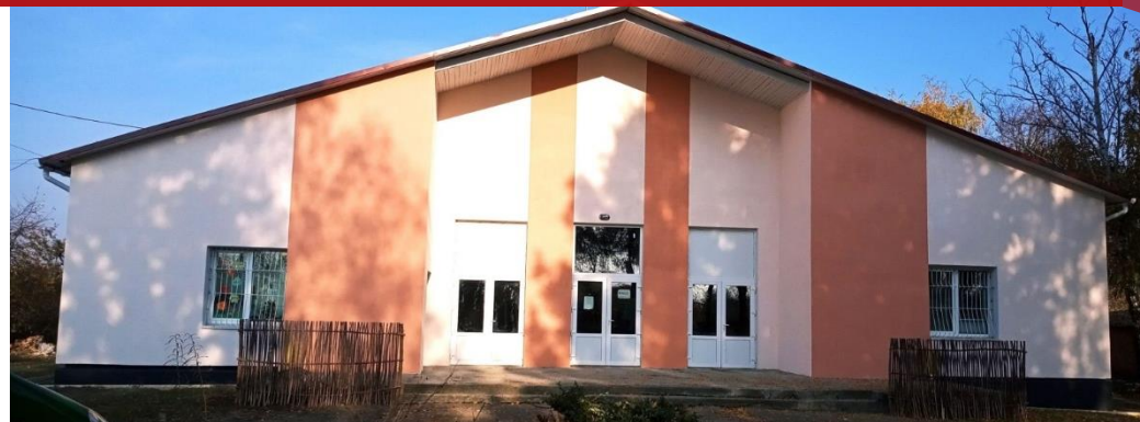
Капітальний ремонт будинку культури Райгородська ОТГ
