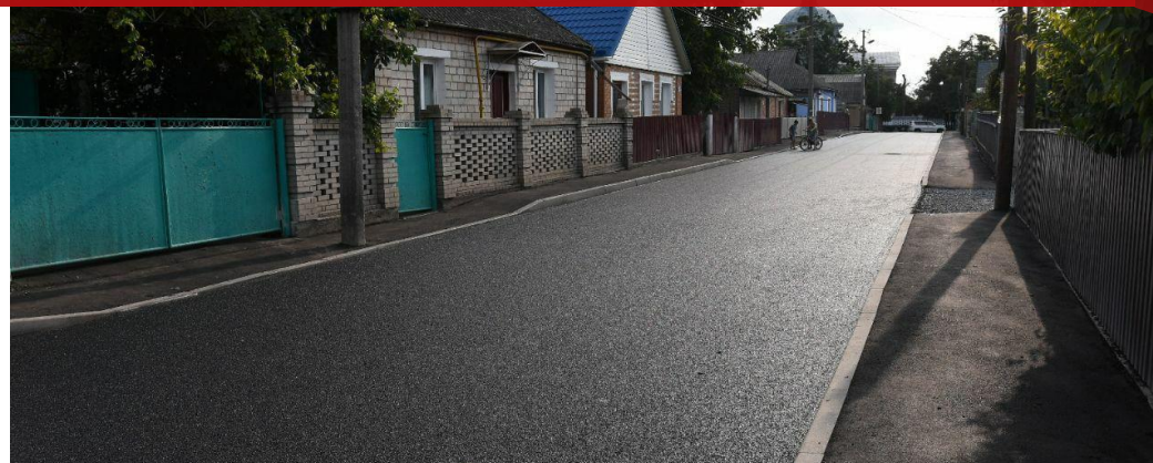
Капітальний ремонт дорожнього покриття Тульчинська ОТГ
