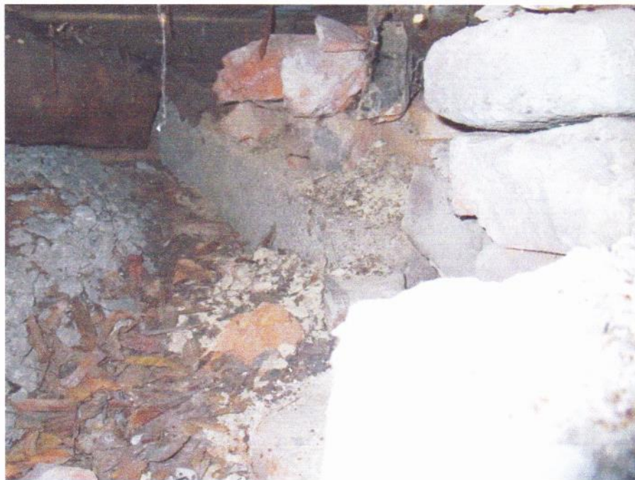
П'ятничани. Кріплення карнизної плити з боку горища палацу. Березень 2013р.
