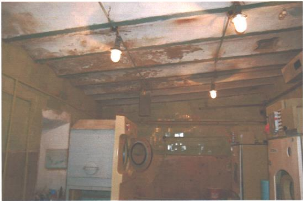
П'ятничани. Інтер'єр. Циліндричне склепіння між металевими балками над пральнею денного стаціонару. Західне крило стайні.(Флігель палацу). Квітень 2013р.
