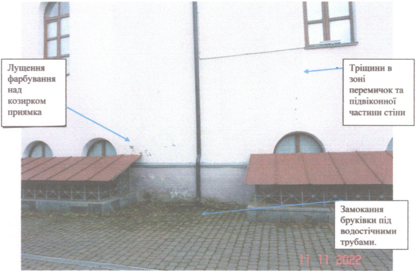
Фото 5. Фрагмент західного фасаду костьолу.
